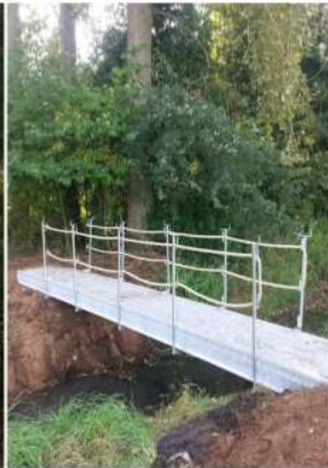
Er werd een brug over de beek te Lozenhoek - Keerbergen geplaatst op voetweg 59 om Keerbergen met Heist-op-den-Berg te kunnen verbinden.
