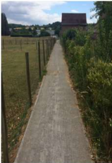
Kortenberg: Voetweg 24 na grondige renovatie. Het gebruikte materiaal is ternair zand, licht gebonden met kalk op een waterdoorlatende worteldoek en afgeboord met borduursteen.
