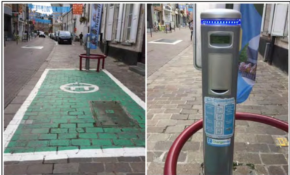
Elektrische laadpalen op de parkings van alle hubs Ook aan de grotere stations zoals in Tienen, Aarschot en Leuven of zoals in Diest; in het stadscentrum. (foto: Koning Albertstraat, Diest)
